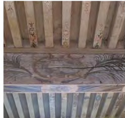
Au siège de l'association Patrimoine et développement, un plafond à la française a été découvert lors de travaux. Une belle surprise pour l'association qui travaille dans un cadre proche de ses préoccupations. Photo D. P.
