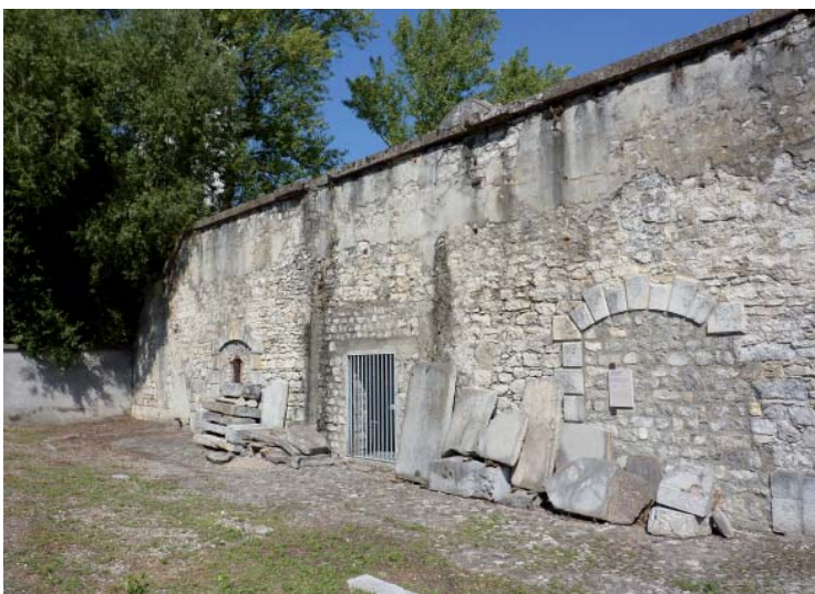
Façade du XIX e siècle (époque des fortifications du Général Haxo)
