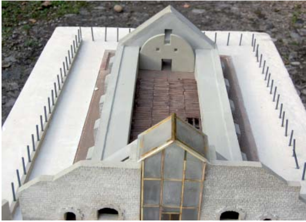
Maquette - Intérieur présentant le plancher de bois soutenu par des dés en pierre et un détail de celui-ci
