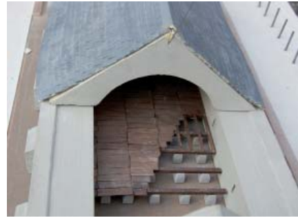
Maquette - Intérieur présentant le plancher de bois soutenu par des dés en pierre et un détail de celui-ci
