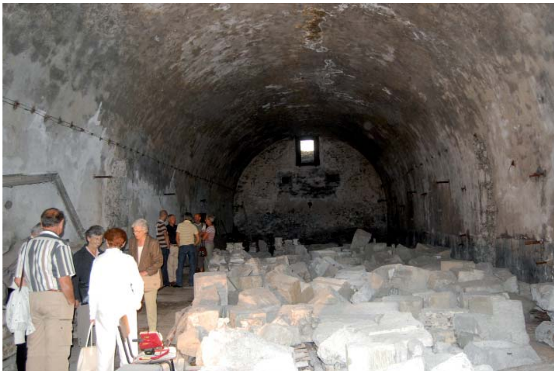
Intérieur de la Poudrière utilisé en lieu de stockage de vestiges archéologiques
